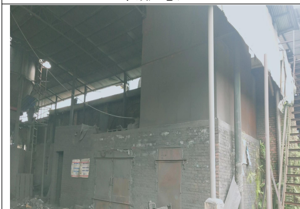
磨粉车间布袋除尘器
